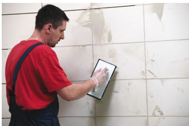
CE 40 zatřete důkladně gumovou stěrkou do spár mezi obklady tak, aby byly spáry úplně vyplněné.
