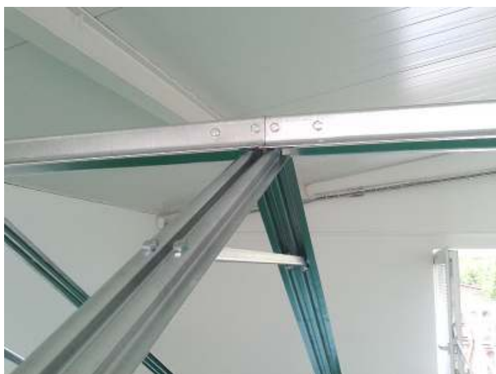
Pohled na hřeben skleníku.
