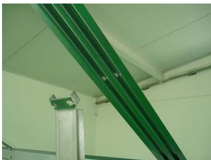
Spojení střešní výztuhy (24) a střešního sloupku (15).
